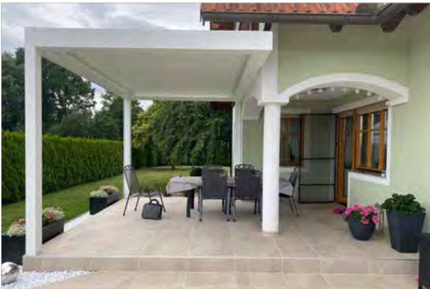
Lamellendächer können bis zu einem Drittel der Gesamtlänge, jedoch maximal 150 cm auskragen.
