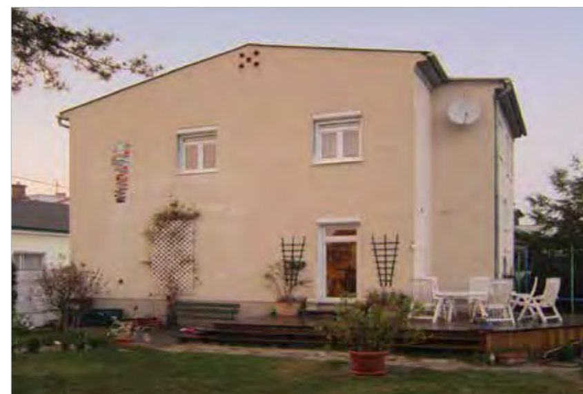
Die bestehende Holzterrasse wurde entfernt und die Fassade erneuert.
