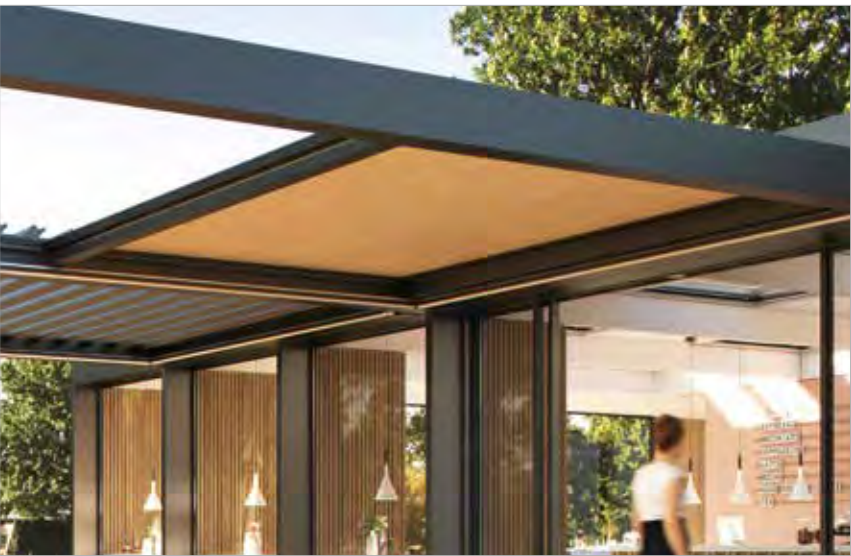
Das Wasser sammelt sich in der mitfahrenden Dachrinne und wird über die Ecksäulen abgeleitet.
