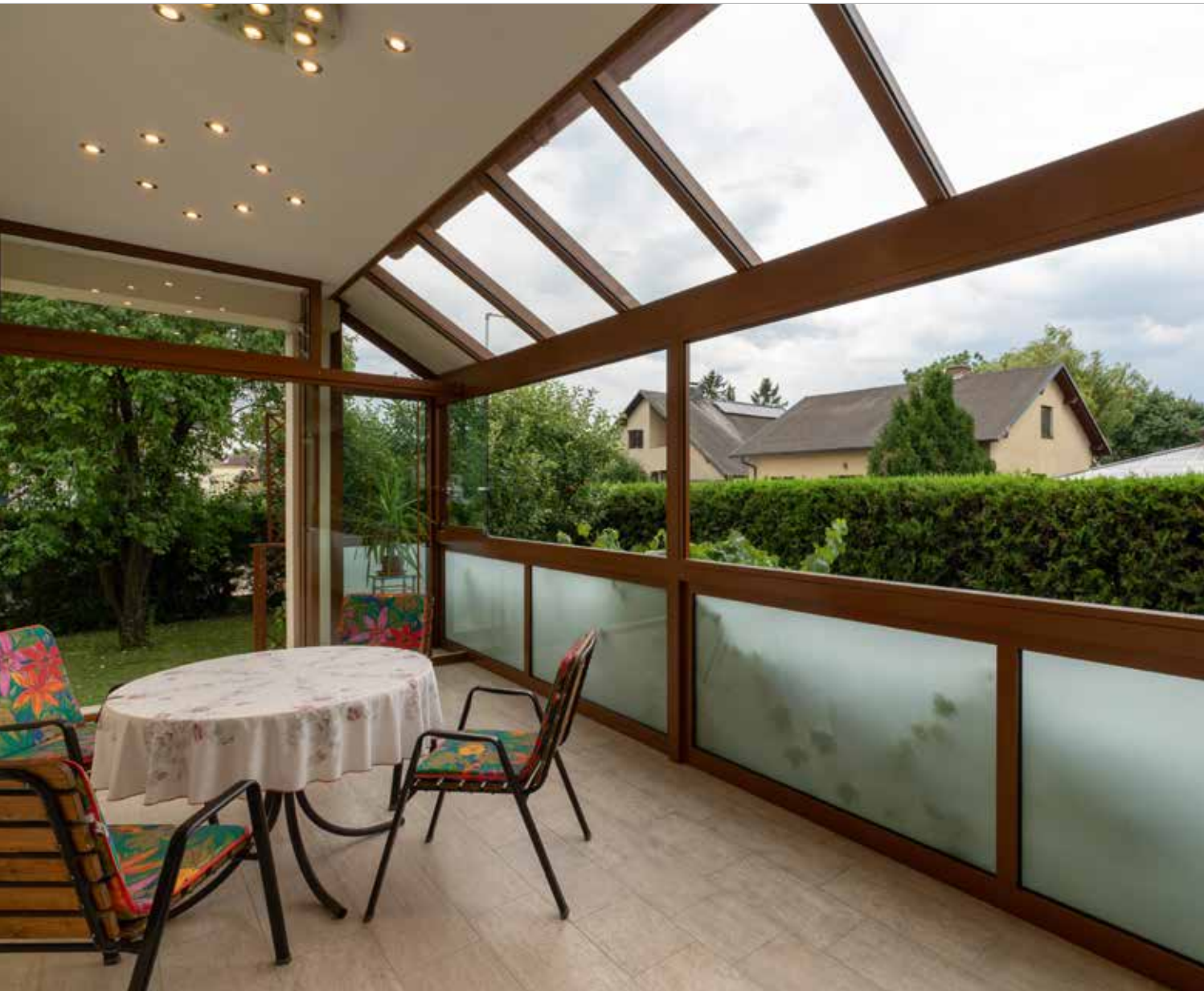
Die Glasbrüstung mit Mattglas ersetzt ein bestehendes Geländer.
