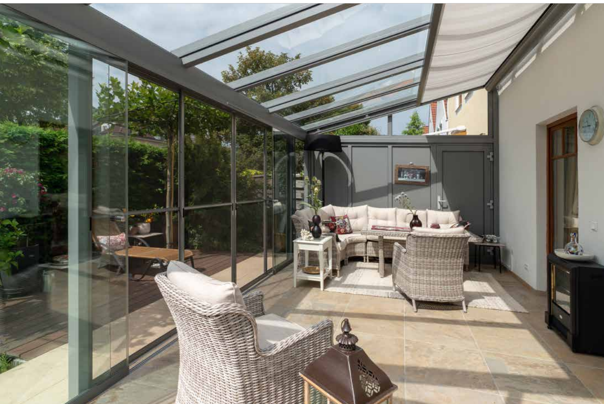
Sichtschutz zum Nachbarn mit Wandpaneelen aus Aluminium mit Revisionstüre.
