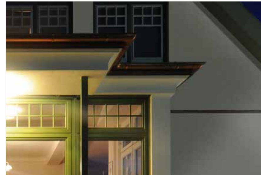
Gesims mit Hohlkehle und Kupferdachrinne, 25 mm Klebesprossen in den Oberlichtern
