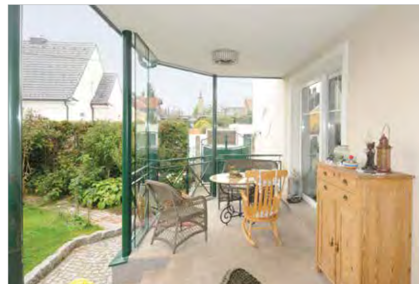
Die Glasschiebetüren gehen bis zur Decke. Die Boden- und Deckenschienen sind eingelassen.
