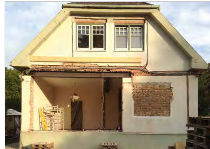
Ein Breitflansch I-Träger mit 30x30 cm Querschnitt trägt die Dübelbaumdecke der darüber liegenden Kinderzimmer.
