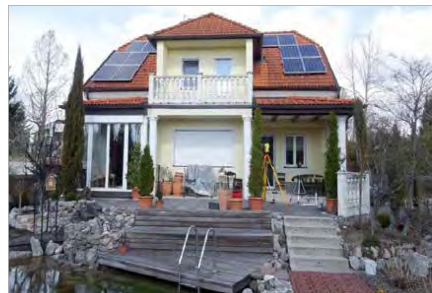
Das Haus vor dem Umbau.
