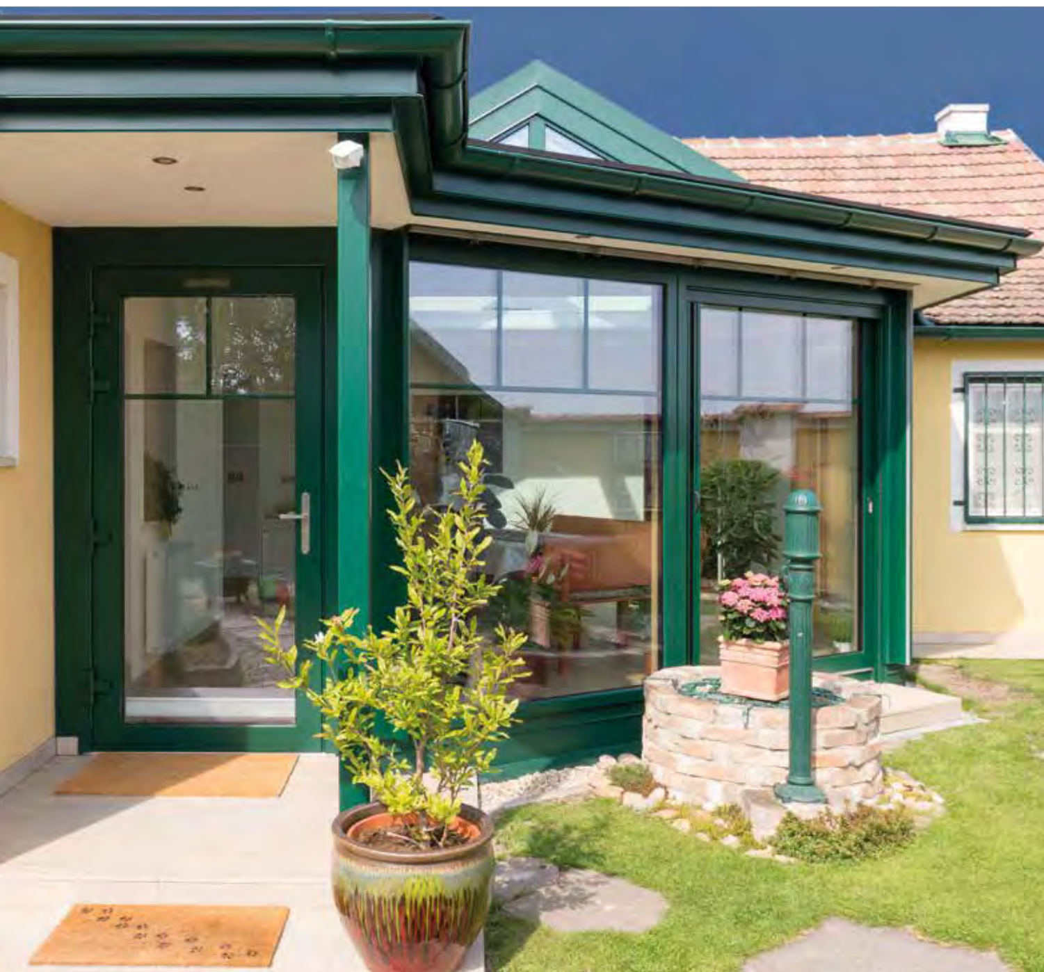
Das mächtige Vordach mit eingebauter Beleuchtung wird von einer Metallsäule getragen.
