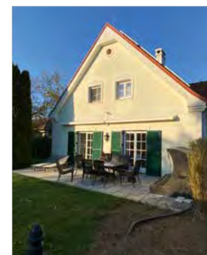
Das Haus vor dem Umbau.
