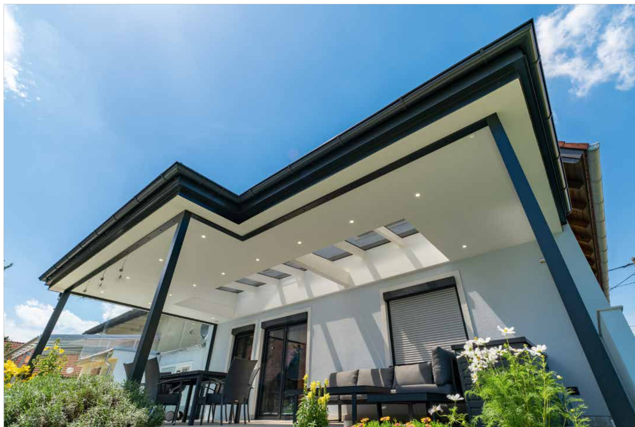
Das Glasdach bietet ausreichend Tageslicht für die Wohnräume, dennoch ist der Terrassentisch im Schatten. Seitlich sind Glasschiebetüren montiert, vorne können diese später ergänzt werden.
