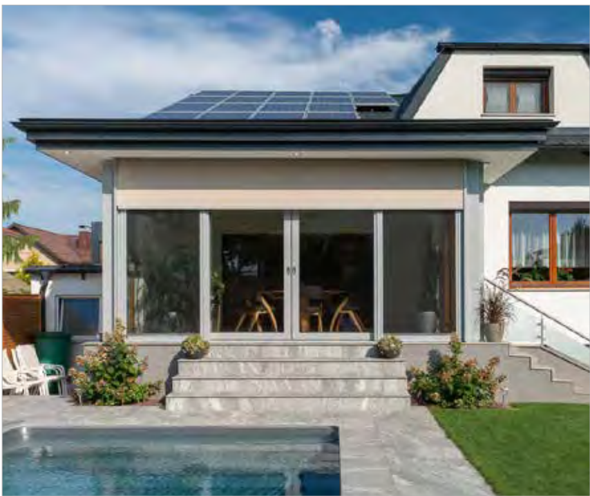
Zipline in den Dachvorsprung des Wintergartens eingebaut.
