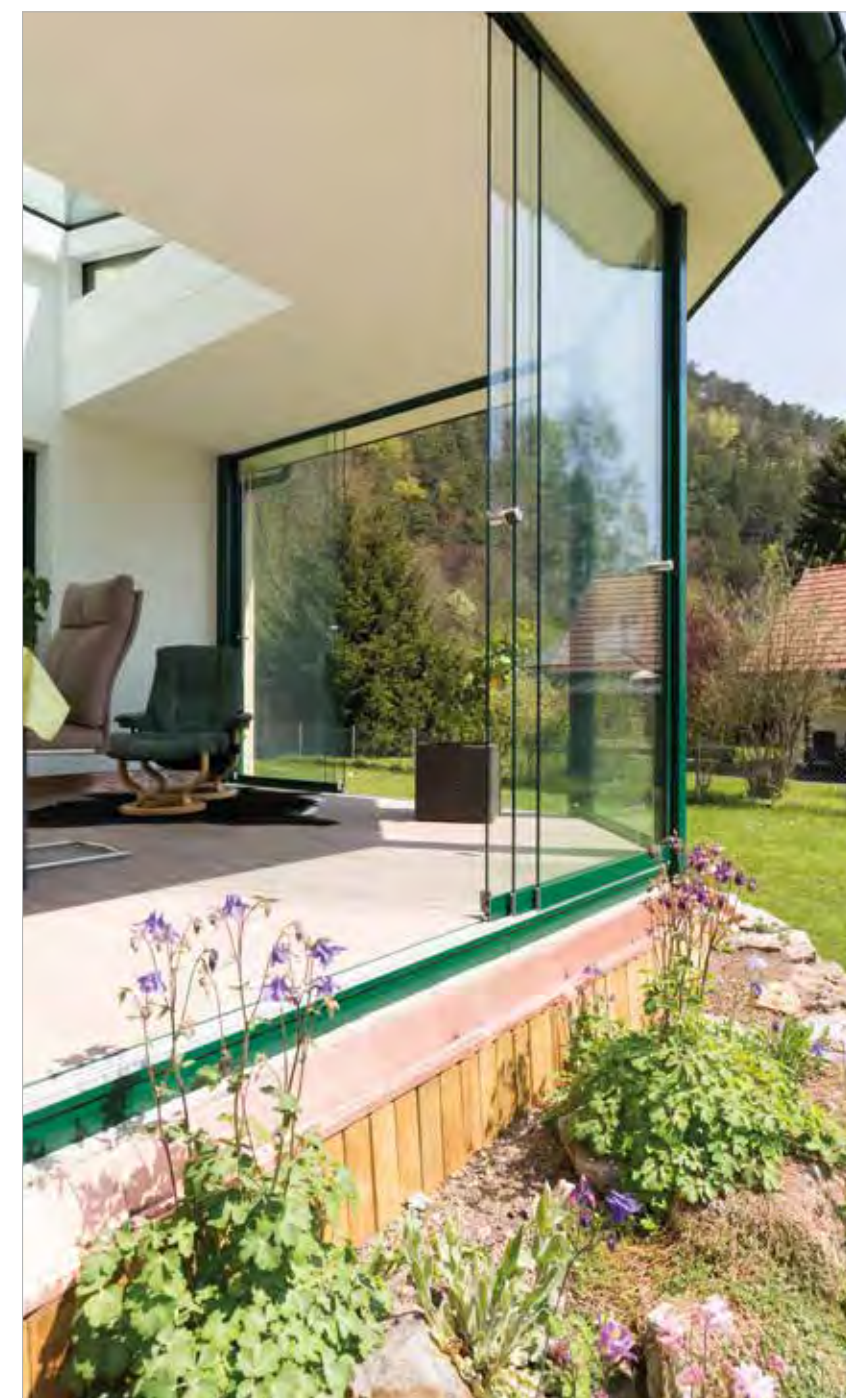
Glasschiebetüren mit 10 mm ESG Sicherheitsglas, Bodenschienen in den Fußboden versenkt.
