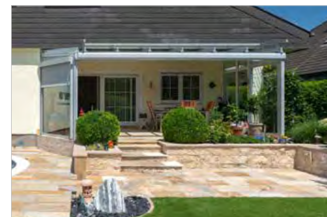
Dach mit 550 cm Spannweite ohne Mittelsäule.
