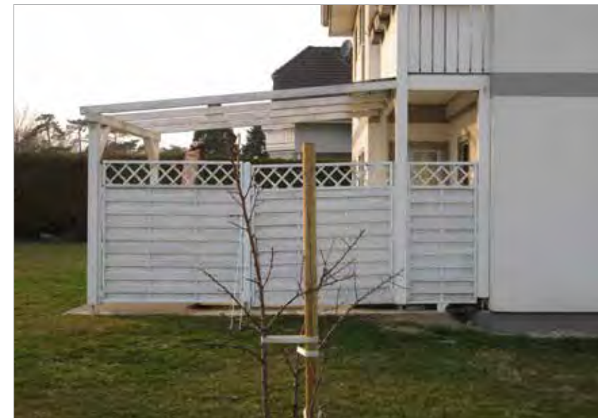
Bestehende Pergola vor dem Umbau.
