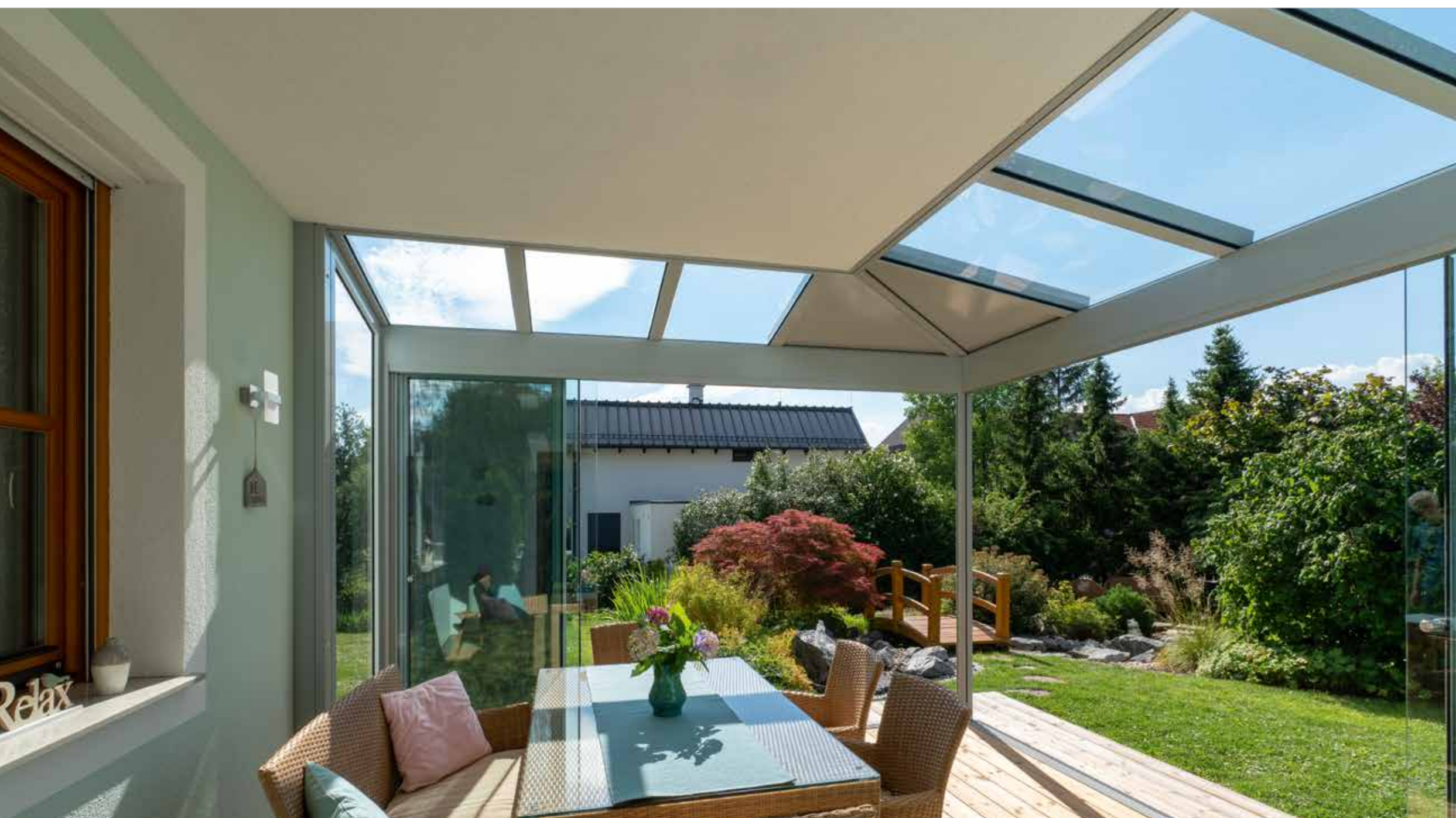
Dreieckige Gläser sind schwer zu beschatten. Alupaneele im Eckbereich sind eine Alternative.
